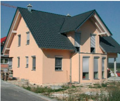
Ein mit dem neuen VIP-Wärmedämmverbundsystem ausgestattetes Demonstrationsgebäude bei Giengen/Brenz. © Fraunhofer ISE
